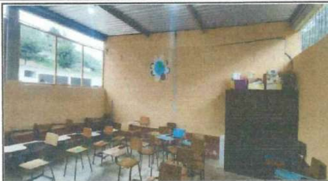
Foto 2: parte trasera del aula reparacion y repello y cernido de paredes alizado de muro.
